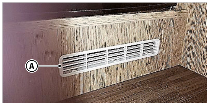
Afb.6.1 - Permanente ventilatieopeningen
