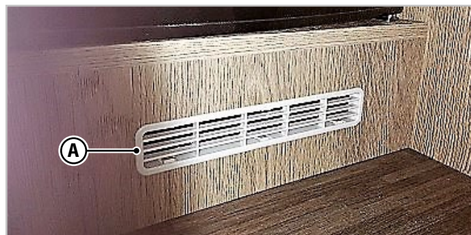
Fig.6.1 - Aberturas de ventilación permanentes
