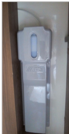
Fig.6.41 - Nivel de mezcla de glicol
